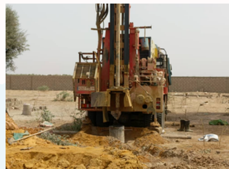
Pruebas iniciales con la perforadora
